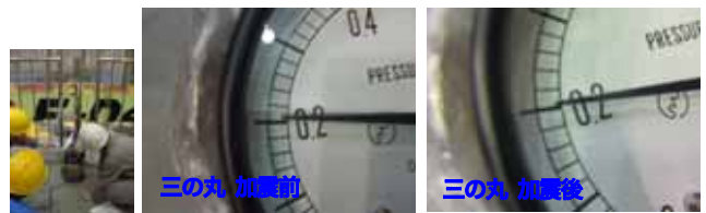
写真-4 加震前後の配管内圧力の状況
