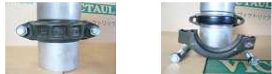
写真10 回収したハウジング継手
