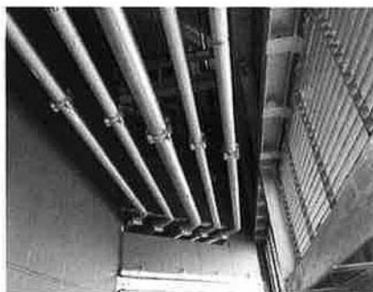
写真－1 納入施工実績事例：某所向け空調配管，雨水配管
