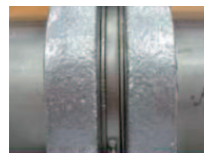
メタルタッチによる 締め付けの目視確認
